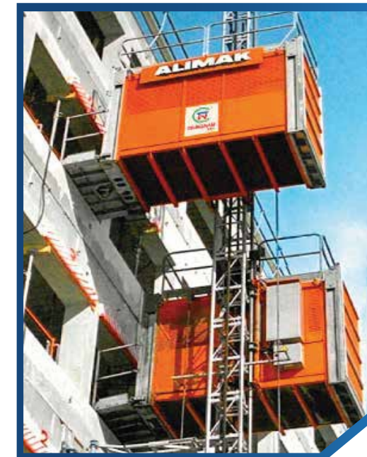
Thiết bị: Máy vận thăng Nước SX: Trung Quốc Số lượng: 03 Tính năng: Vận chuyển công nhân, vật tư lên cao
