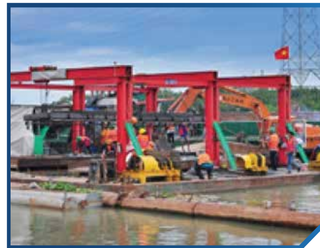
Thiết bị: Thả thả đá - Nước SX: Việt Nam Số lượng: 04 - Công suất: 400-500 m 2 /ngày Tính năng: Thả đá gia cố lòng sông
