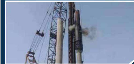
Thiết bị: Búa Diesel 3,5T Nước SX: Trung Quốc Số lượng: 10 - Tính năng: Hạ cọc tròn DUL BTCT D500A
