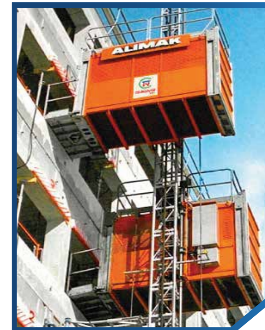
设备：施工升降机 产地：中国 数量：3台 用途：垂直运输人员及材料
