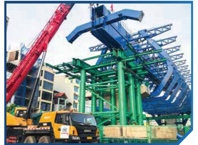
设备：MSS移动模架造桥机 产地：挪威 数量：1台
