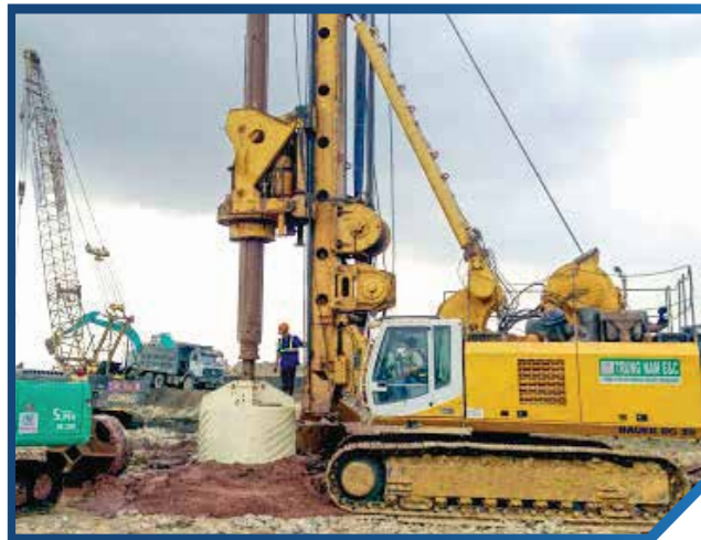
设备：旋挖钻机 Bauer (BG36) 产地：德国 数量：3台
