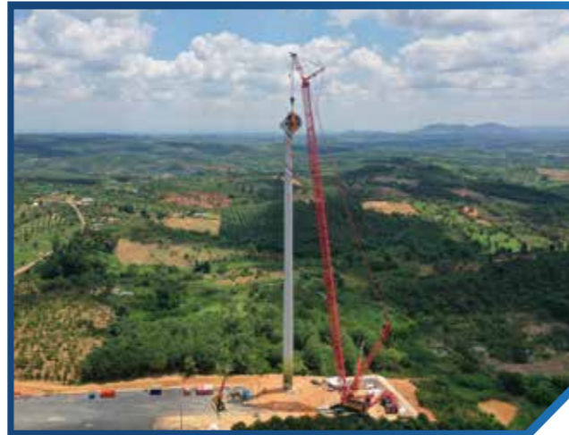
设备: 1250吨履带起重机 产地: 中国 数量: 5台
