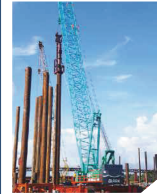
设备: Clark / Lima 300吨履带起重机 产地: 日本 数量: 3台
