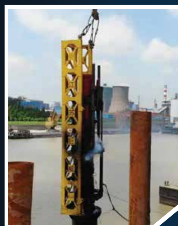
Thiết bị: Búa Diesel 3,5T Nước SX: Trung Quốc Số lượng: 06 Tính năng: Hạ cọc tròn DUL BTCT D350A
