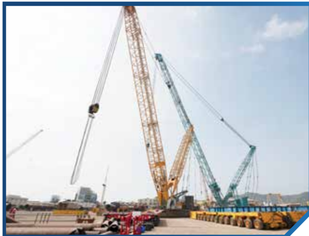
Thiết bị: Cầu bánh xích 750T Nước SX: Đức Số lượng: 01
