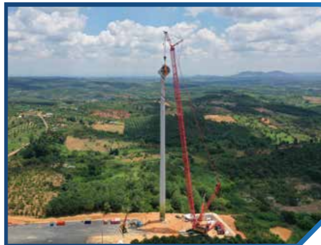
Thiết bị: Cầu bánh xích 1250T Nước SX: Trung Quốc Số lượng: 05
