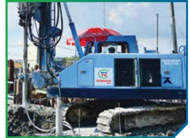
Thiết bị: Máy khoan cọc XMĐ Nước SX: Nhật Bản - Số lượng: 04 Tính năng: Khoan, phụt vữa gia cố nền móng
