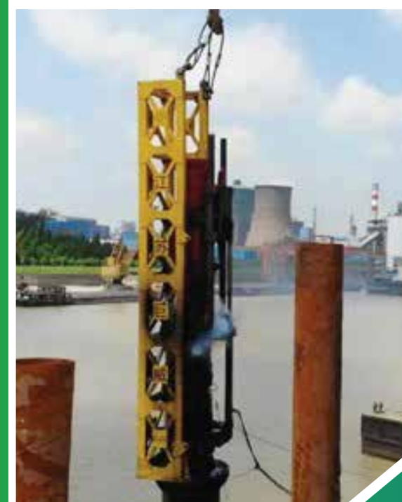
Thiết bị: Búa Diesel 2,5T Nước SX: Trung Quốc Số lượng: 06 Tính năng: Hạ cọc tròn DUL BTCT D350A
