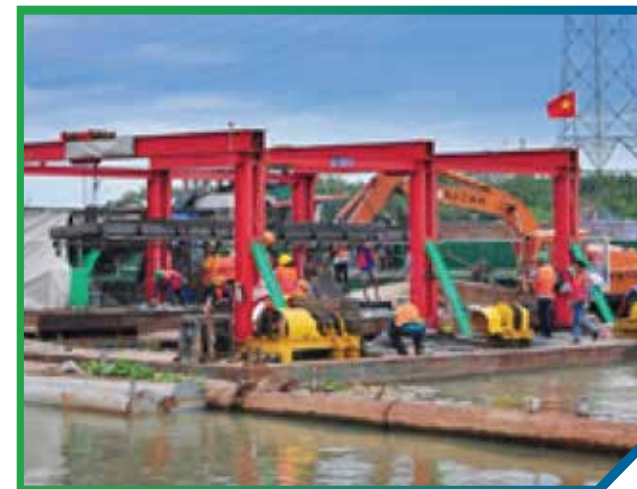
Thiết bị: Thả thảm đá - Nước SX: Việt Nam Số lượng: 04 - Công suất: 400-500 m 2 /ngày Tính năng: Thả thảm đá gia cố lòng sông
